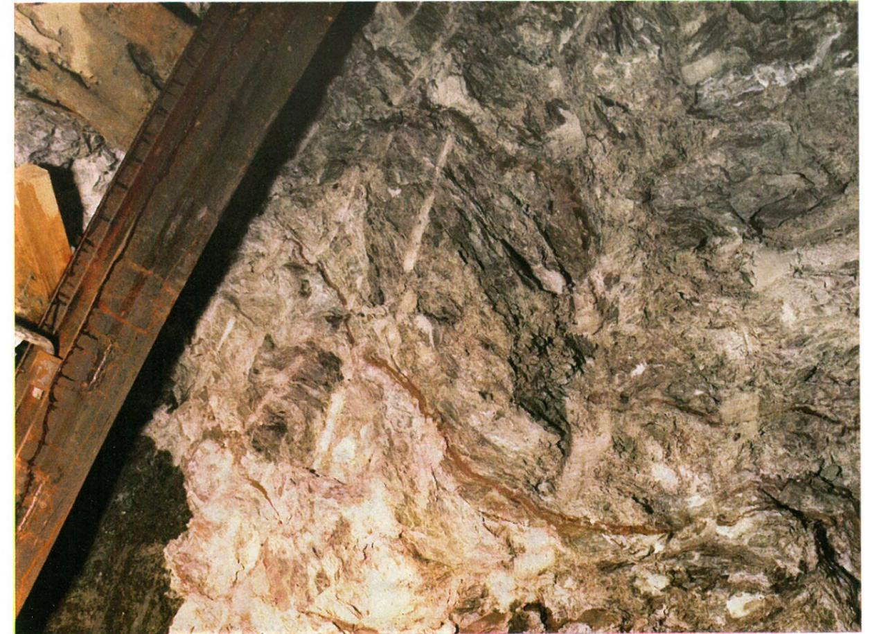
Fig. 6 - Particolare del fronte di scavo. Come si può facilmente notare non vi è traccia di « sineresi ». Le venature marron sono formate dal gel caricato; se fosse gel puro, avendo provocato il « claquage » un'apertura dello spessore di 2-3 cm, si sarebbe senza dubbio innescato il fenomeno della « sineresi ». Qui invece tutto appare normale e completamente asciutto. Il fronte di scavo è rimasto allo scoperto, non armato, per più di 20 giorni durante le feste natalizie.
