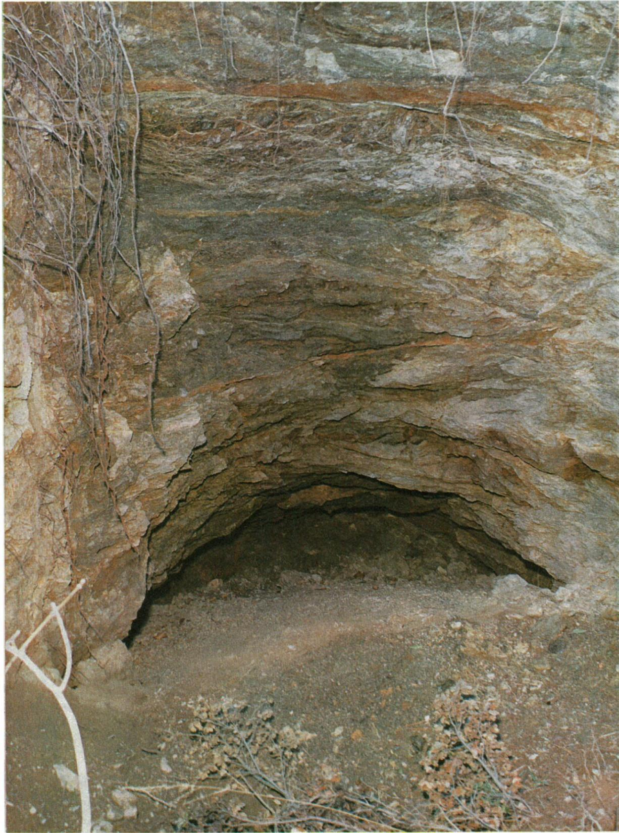
Fig. 4 - Vista dall'alto della collina, sopra l'asse della galleria in costruzione, della bocca del « camino » formatosi in seguito al dissesto che ha riempito di materiale franato 30 m circa di scavo già completato.
